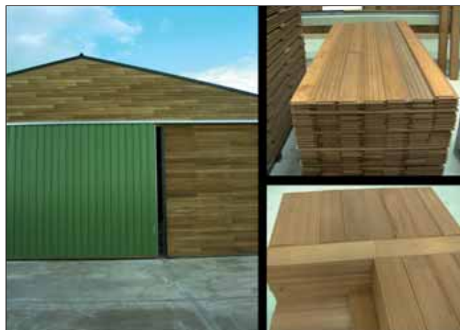
Le bâtiment de l'association « Bois durable de Picardie » à Brie (bardage en peuplier modifié thermiquement). A droite, 2 exemples de débouchés : des lames de bardage et du bois de terrasse.
