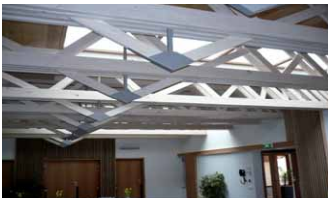
La charpente en peuplier de la salle des fêtes de Lezennes.
